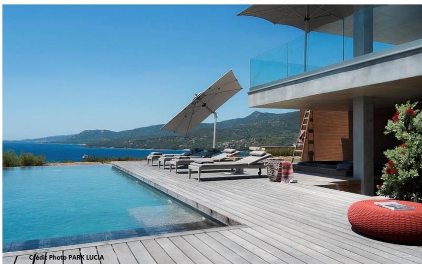
Figure 7 : Réalisation de terrasse en frêne THT, profil lame lisse pour fixation invisible B-Fix®, 21 x 140 mm Villa de luxe Park Lucia, Propriano, Corse.
