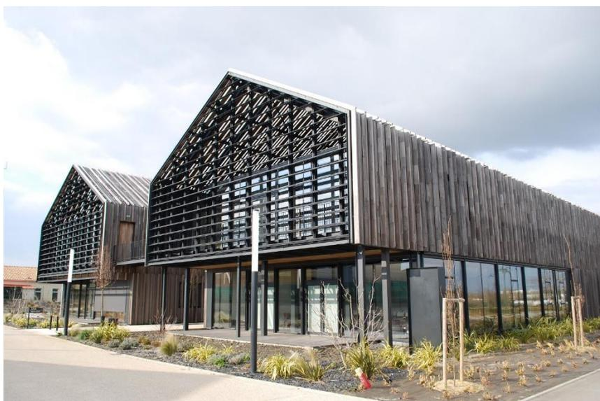
Figure 6 : Réalisation de bardages type claire-voie et plat en peuplier THT abouté, sections sur-mesure 21 x 68 et 135 mm, 45 x 180mm, 32 x 100 et 200 mm. Siège de la CC de Pornic (44).
