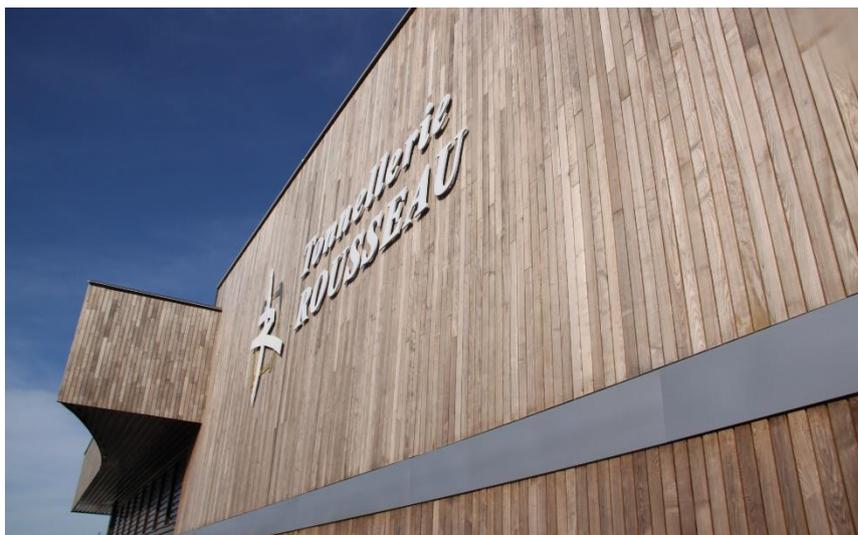
Figure 5 : Réalisation d'un bardage en frêne abouté thermotraité à 210°C, section 21 x 90mm, fixation par clip invisible Juan. Tonnellerie ROUSSEAU, Couchey (21).
