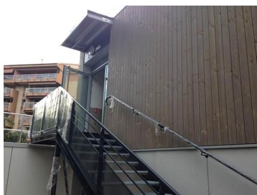
Tous les éléments d'accès ou de jonctions tels que les escaliers, les coursives d'accès handicapés ont été livrés préassemblés permettant une pose en temps record.
