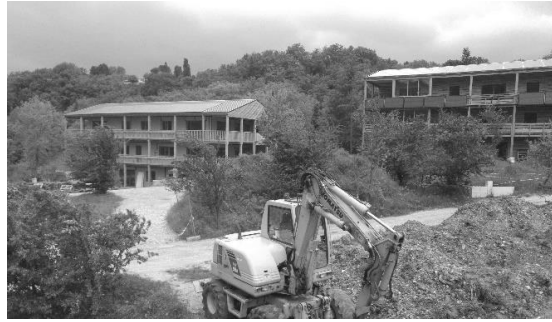
Vue d'ensemble des 2 premiers bâtiments
