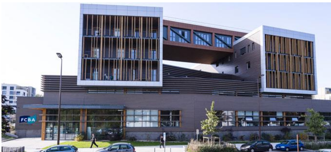
Le siège social et laboratoire du FCBA réalisé par l'Atelier 4+, implanté à la Cité Descartes, à Champs-sur-Marne. © Epamarne / Architecte : Atelier 4+ / photo : Antoine Meyssonier
