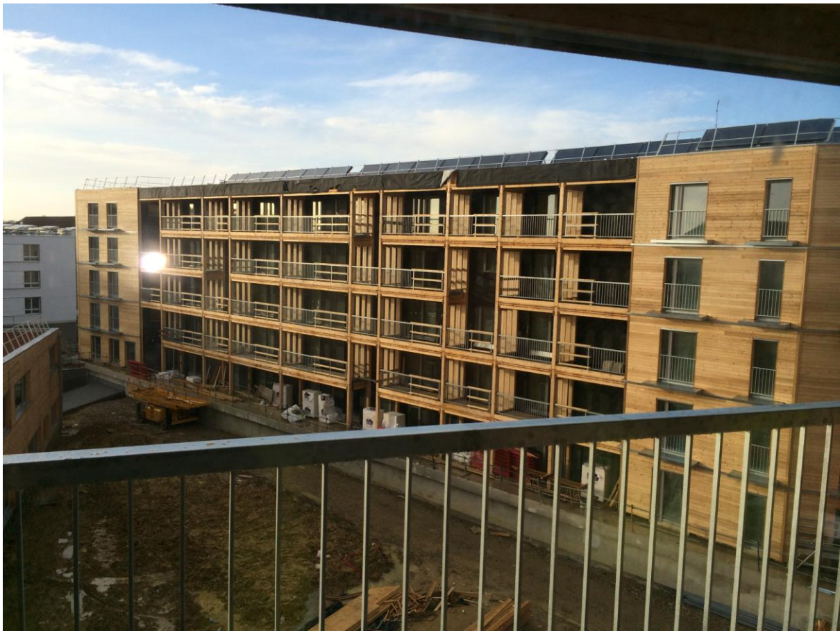
Vue depuis une loggia du quatrième étage, bâtiment B
