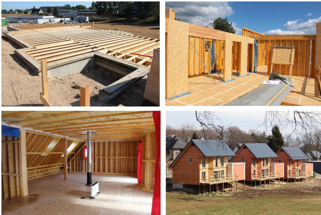
Dalle bois sur longrines – Mur sur plancher de RDC – Etage avec passage du conduit de fumée Façades avec pare-pluie de protection en attendant la finition en enduit projeté sur isolant (EHI).
