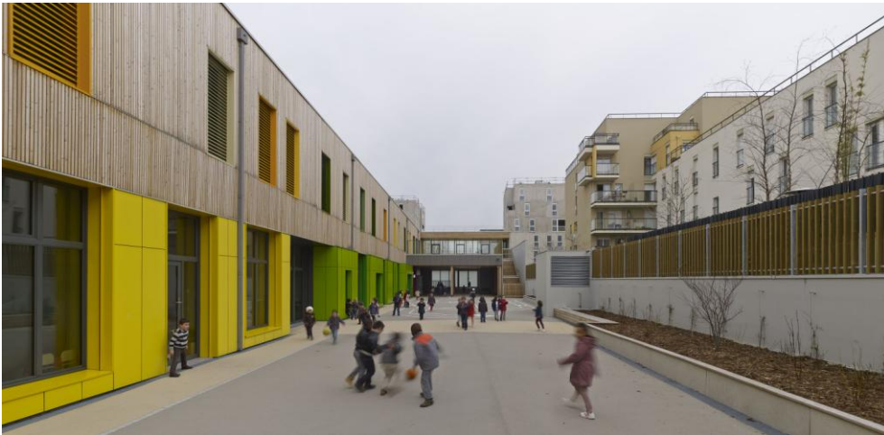
Vue de la cour maternelle. L'ensemble des fenêtre est équipé de stores à lames orientables pilotés par la GTC
