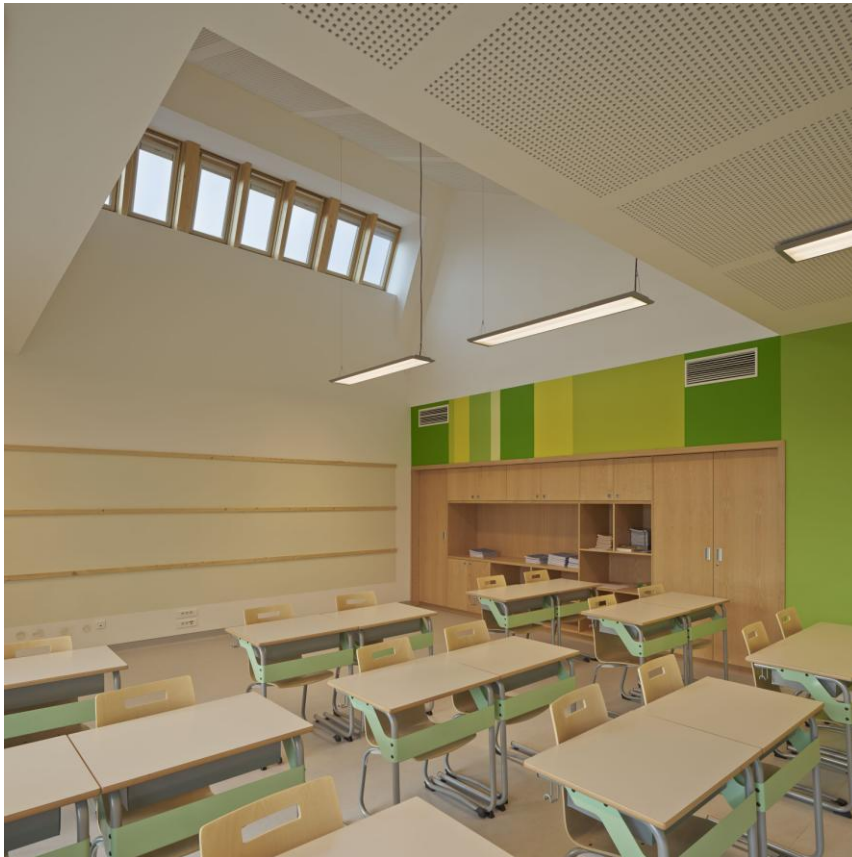
Vue d'une salle de classe : les sheds sont supports de panneaux photovoltaïques et apporte un éclairage zénithal nord qui assure également une ventilation naturelle pour le confort d'été
