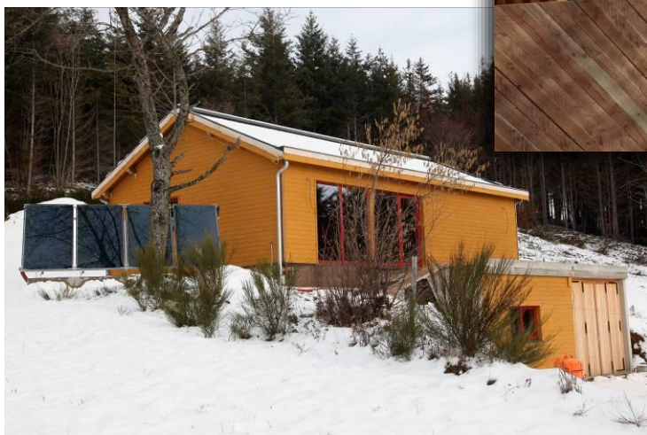
Figure 3 : chantier en cours en mars 2018. L'inclinaison à 60° des capteurs solaires optimise la captation hivernale.
