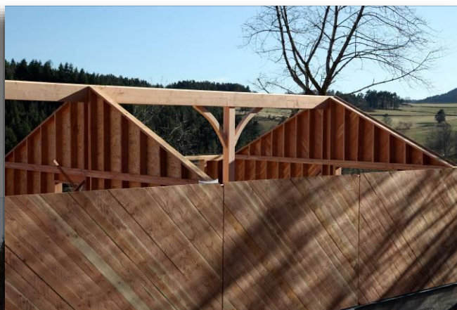
Figure 3 : chantier en cours en mars 2018. L'inclinaison à 60° des capteurs solaires optimise la captation hivernale.
