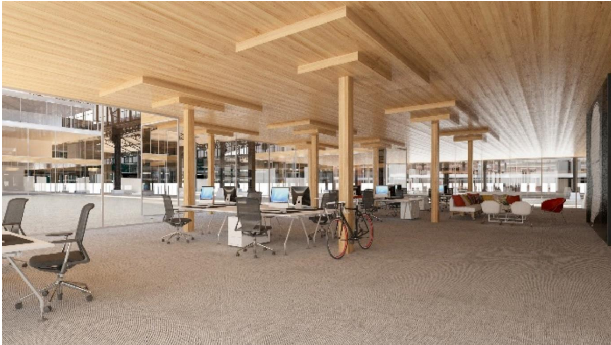
Illustration 7 : Gare Maritime – rendu intérieur de la variante en dalle champignon CLT
