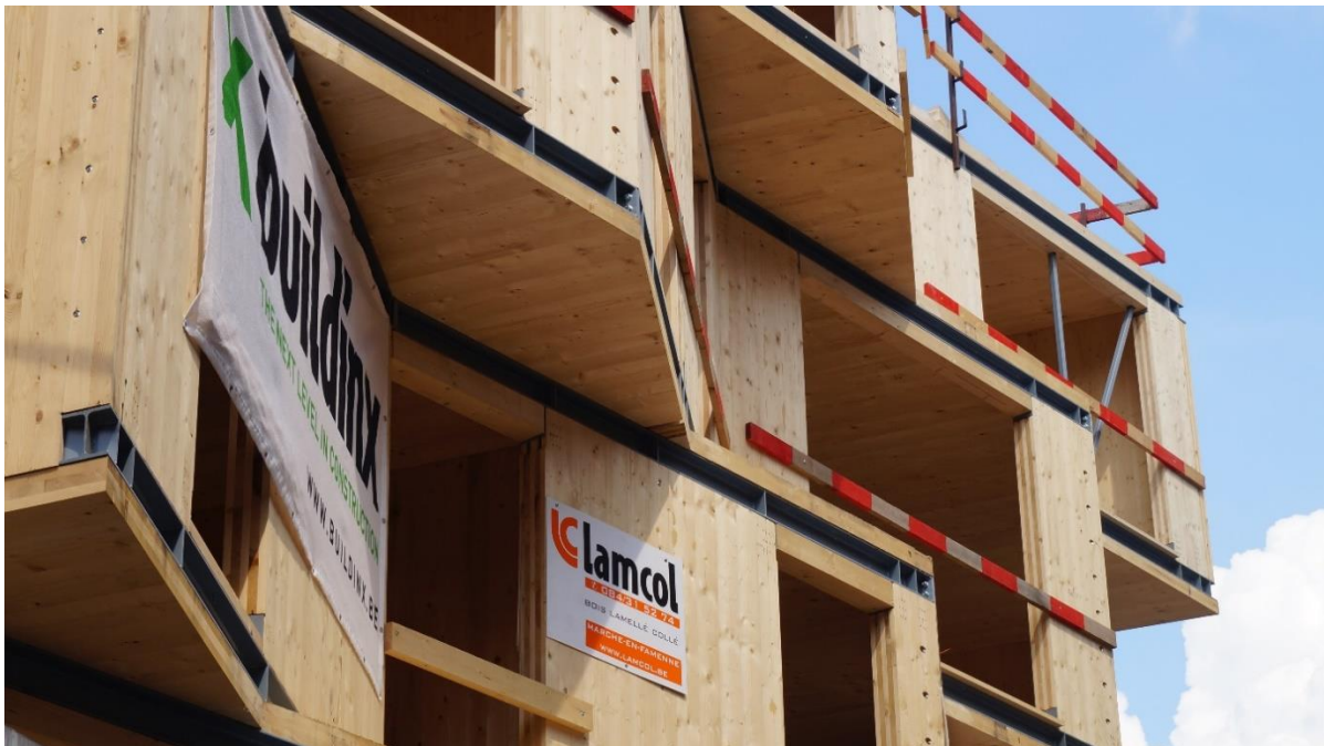
Illustration 1 : Immeuble Inquiétude – Vue de la façade vierendeel
