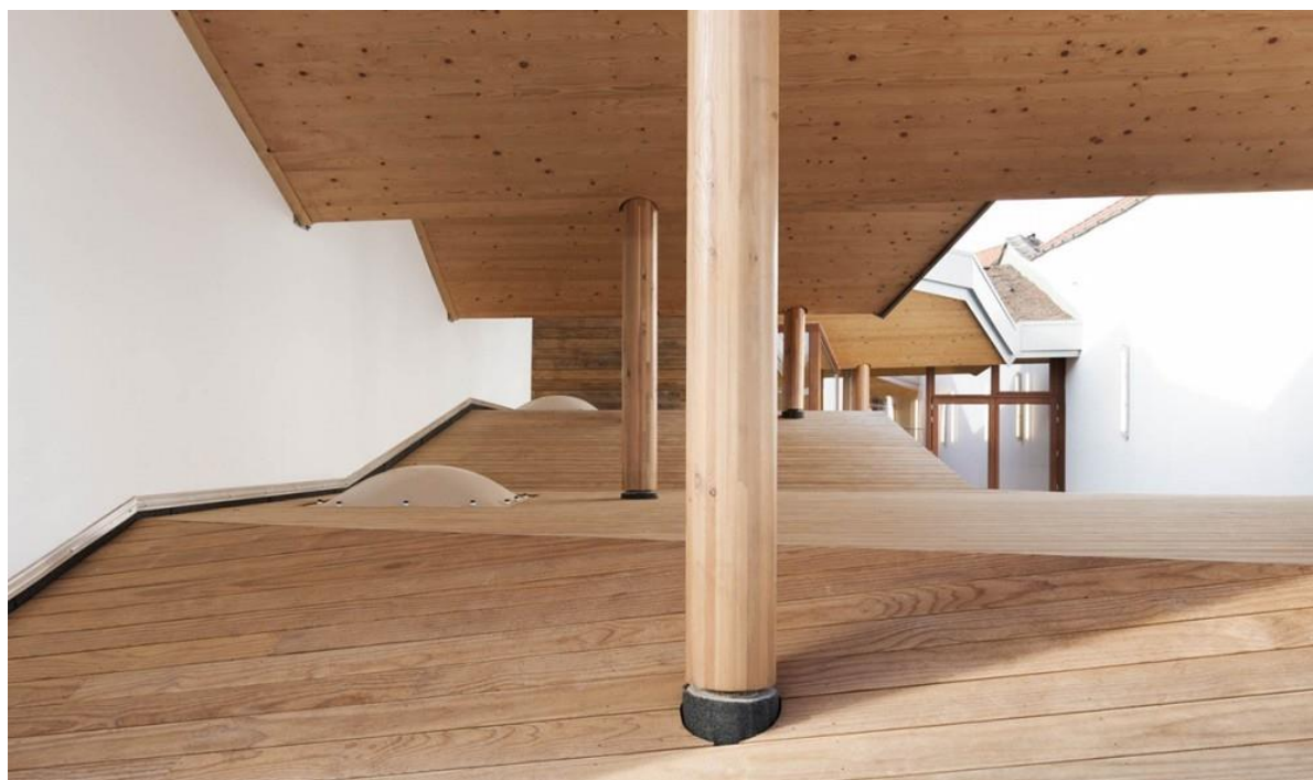
Illustration 3 : Crèche Galatea – Vue de la toiture plissée
