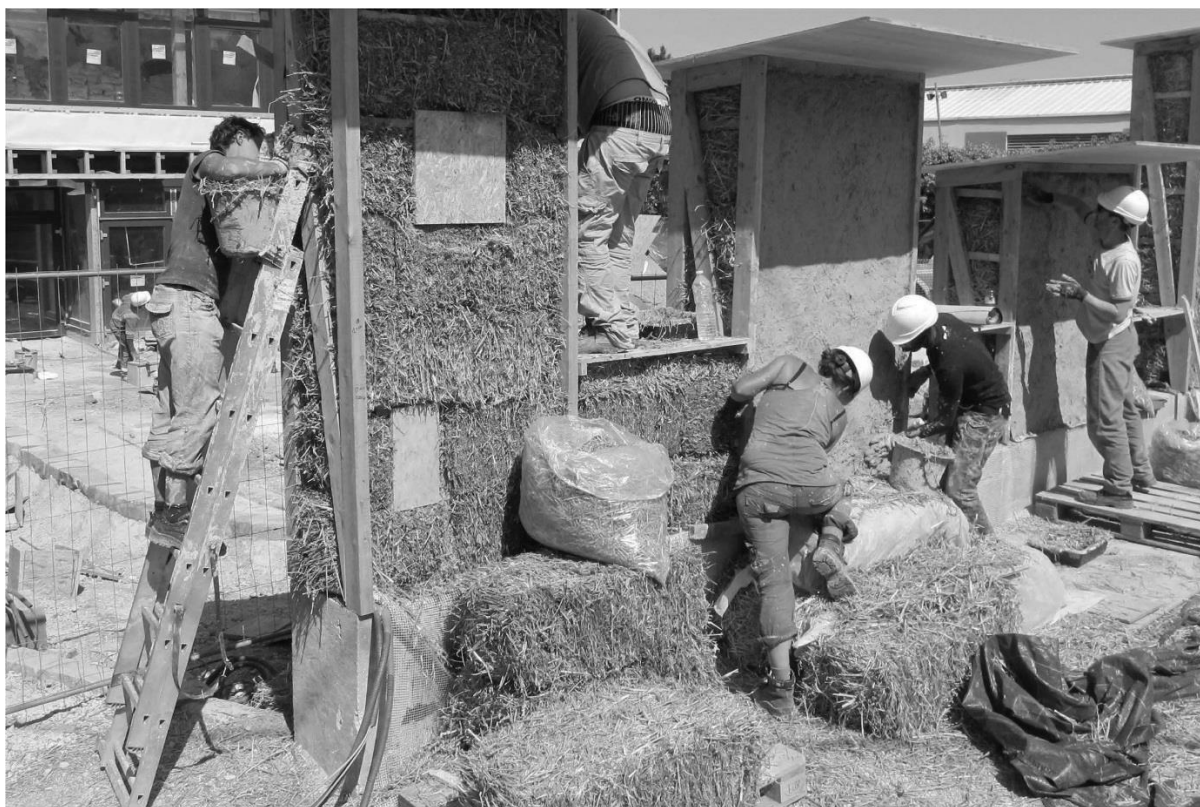
Figure 2 : Construction du mur d'enceinte ensemble
