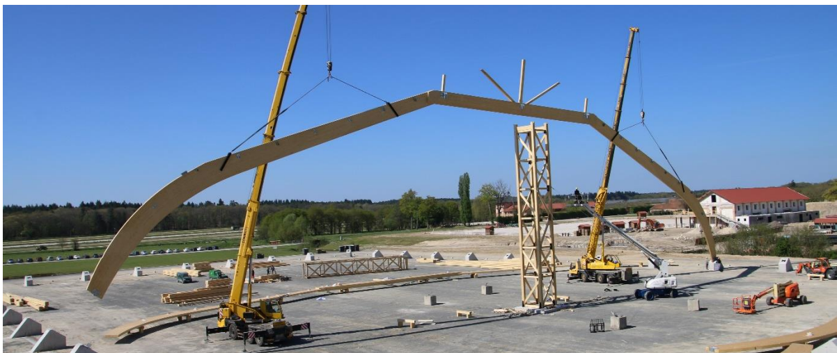
Figure 14 : Levage du premier arc de croupe
