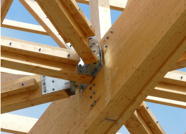
Figure 10 : Contreventement du plan des traverses
