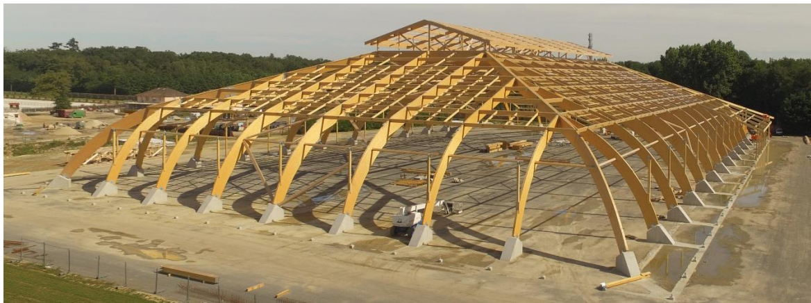
Figure 3 : Vue générale de la structure hors galerie
