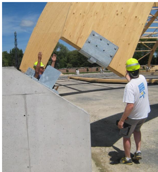
Figure 8 : Pied d'arc équipé de sa ferrure à grain
