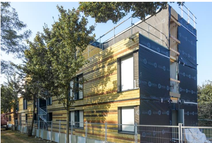
Illustration 2 : En chantier. Modules posés, partiellement finis en ateliers.
