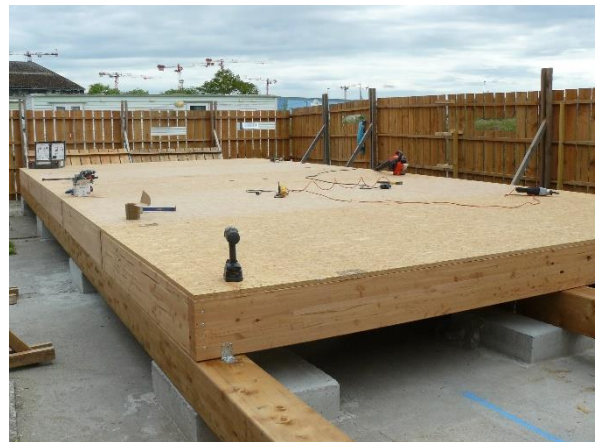
Figure 11 : Installation du plancher sur le site du quai Wilson (©ESB)
