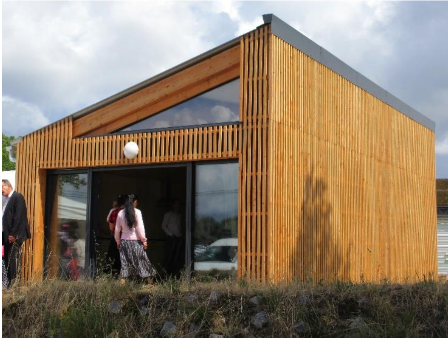
Figure 1 : Le prototype sur le site du quai Wilson le jour de l'inauguration (©ESB)
