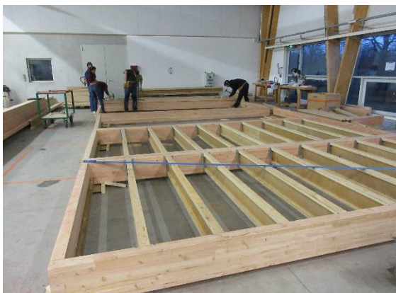
Figure 8 : Fabrication des modules de plancher dans l'atelier de l'École Supérieure du Bois (©ESB)
