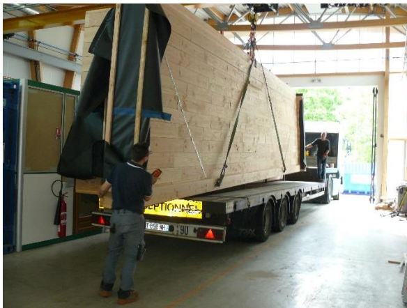
Figure 10 : Chargement des murs en briques sur le camion (©ESB)
