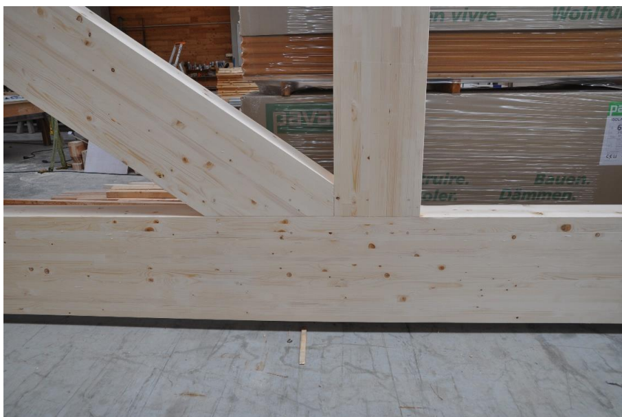
Assemblage Tiges collées Résix® discret et performant
