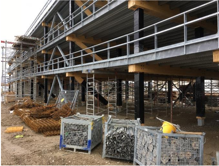
Figure 3 : Photo du chantier
