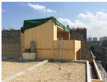
Figure 8 : Aperçu de la structure bois et des niveaux R+6 et R+7 - toiture terrasse
