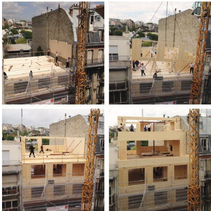
Figure 8 : Aperçu de la structure bois et des niveaux R+6 et R+7 - toiture terrasse
