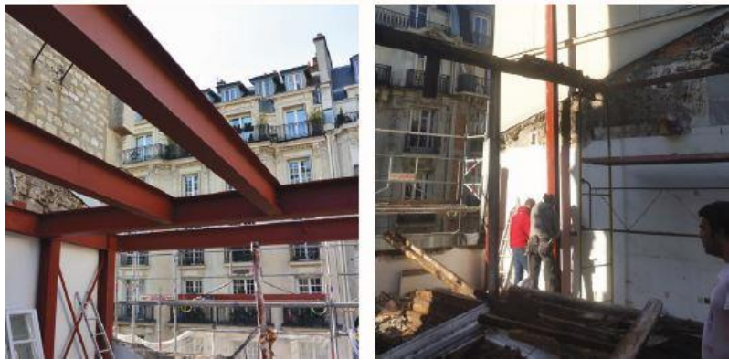
Figure 6 : Démolitions - Pose de la structure métallique
