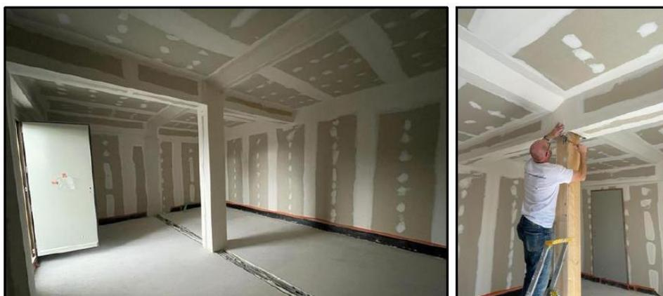
Sous certaines conditions, un ou plusieurs poteaux ou poutres apparentes peuvent être mis en œuvre, qu'ils soient « filants » (plus précisément assemblés par ferrure en âme) ou incorporés dans une cloison.
