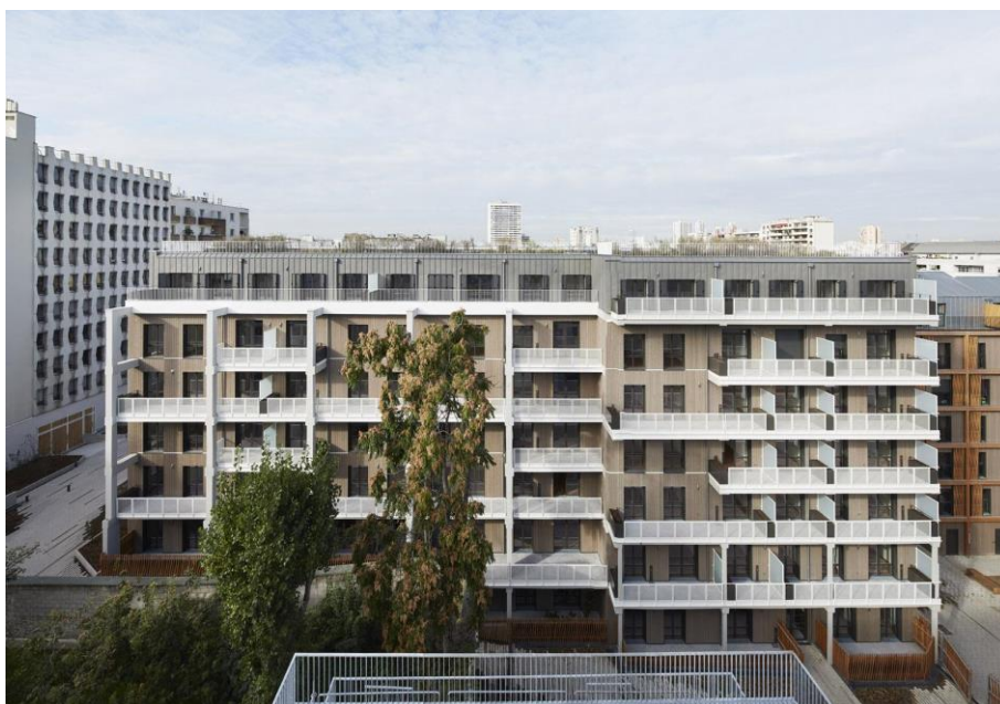
Vue des balcons et des terrasses sur la façade est du bâtiment
