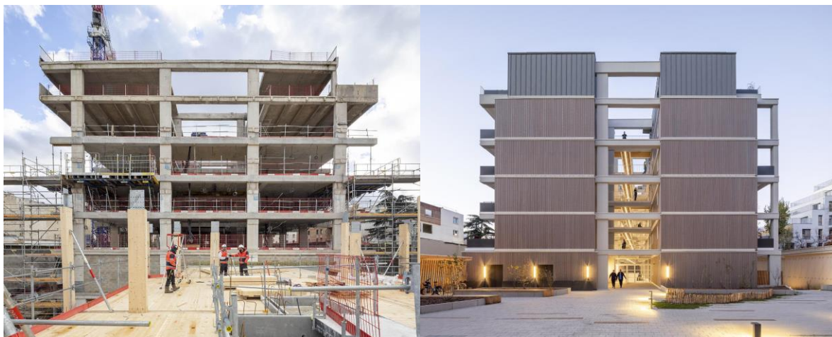
Transformation du parking en logements, avant / après
