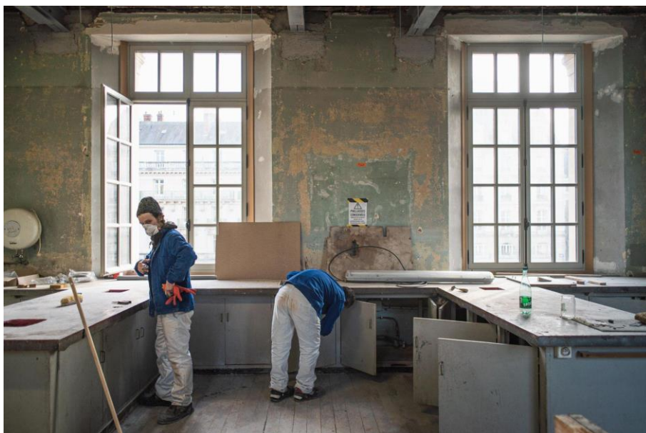
Chantiers-école pour la rénovation des paillasses de l'Hôtel à projets
