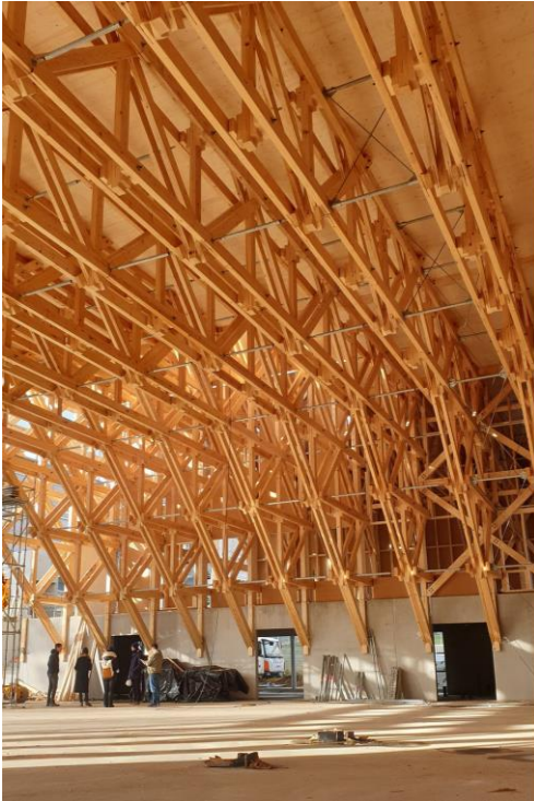
2. Gymnase Jean-Lamour à Nancy en cours de chantier © Studiolada
