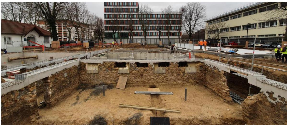
Image 4 : Chainage des murs moellons conservés avant coulage de la dalle du rez-de-chaussée. @ArtBuild
