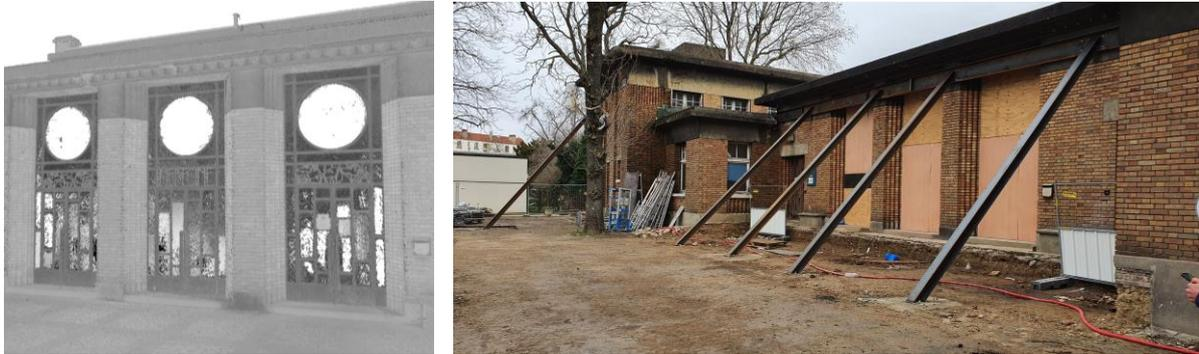
Image 11 et 12 : Façade nord scannée et stabilisée en phase chantier. @ArtBuild
