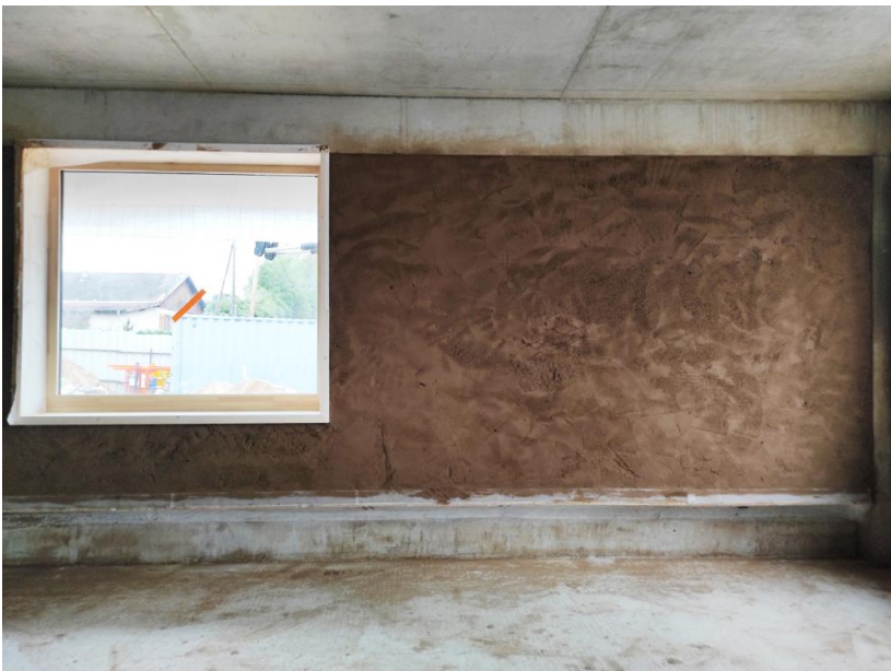
Application du corps d'enduit terre crue
