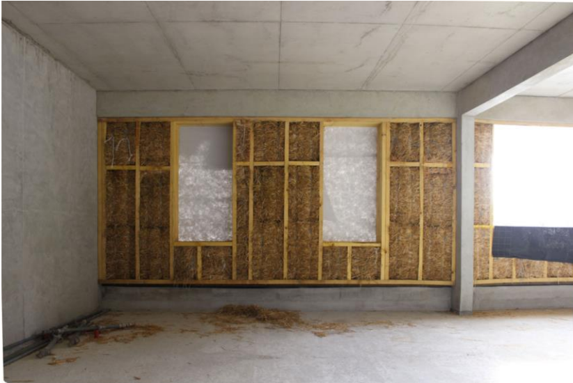
Mise en place des caissons pailles non fermés
