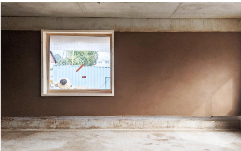
Application de la couche de finition terre crue
