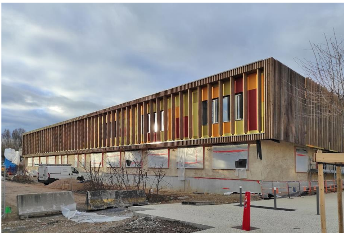
Façade principale du groupe scolaire, orientée au sud
