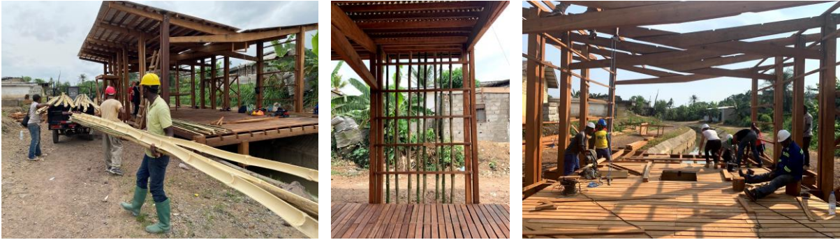
Image 15 : photographies du chantier, crédits : La Fabrique Collective
