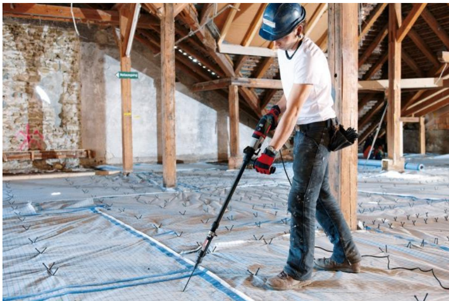
Image 3 : Pose des connecteurs SFS VB avec la machine CF-VB/L
