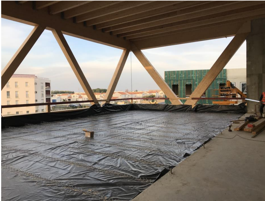
Image 5 : Chantier, connecteurs posés
