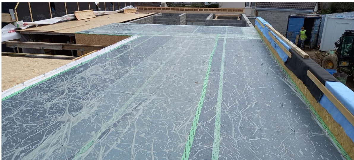
Image 8 : Connecteur SFS VB posé en toiture-terrasse
