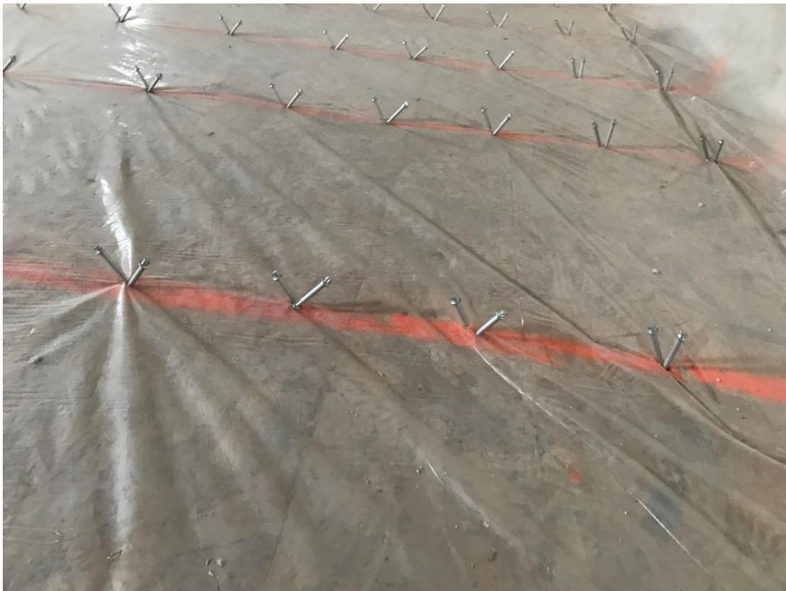
Image 11 : Connecteur SFS VB posé en rénovation
