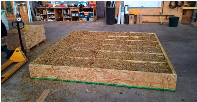
Préfabrication des MOB paille à l'atelier © SDCC
