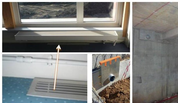
Apports mensuels issus du vide technique pour les locaux possédant un anémomètre à fil chaud au droit de la bouche d'extraction, au cours de la première année.
