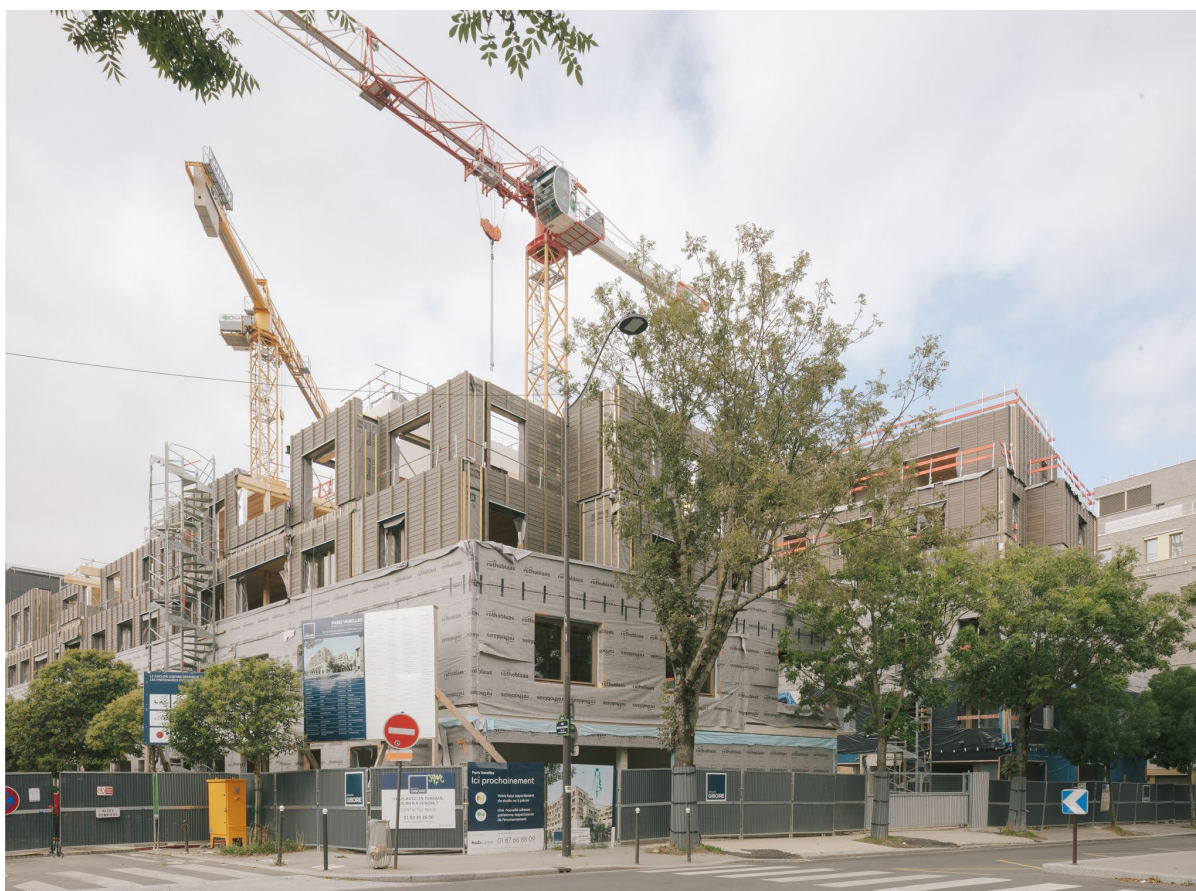
Image 3 : Le bâtiment dans son contexte urbain © Charly Broyez
