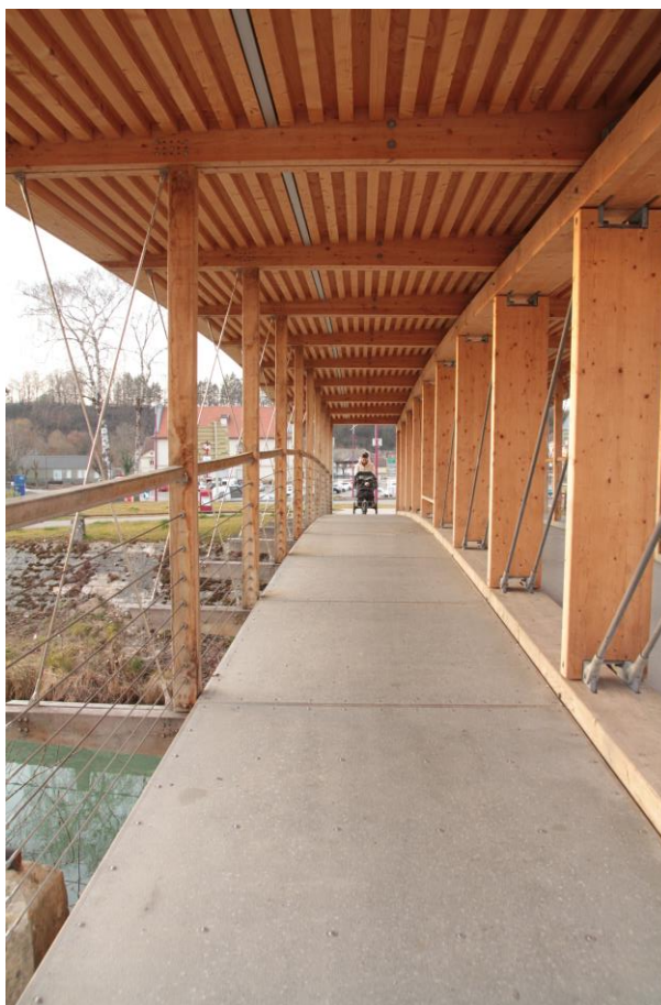
Photo 6 : Vue intérieur avec la poutre centrale
