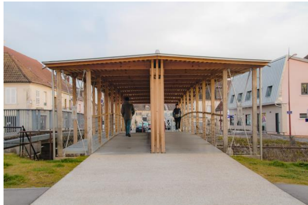
Photo 1 : Entrée de la passerelle
