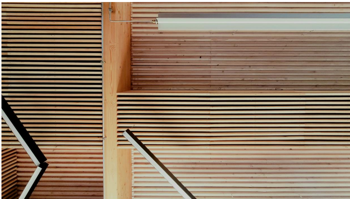
Plafond : sous-face de plancher Lignadal et panneaux Sylvacoustik, radiateurs et luminaires
