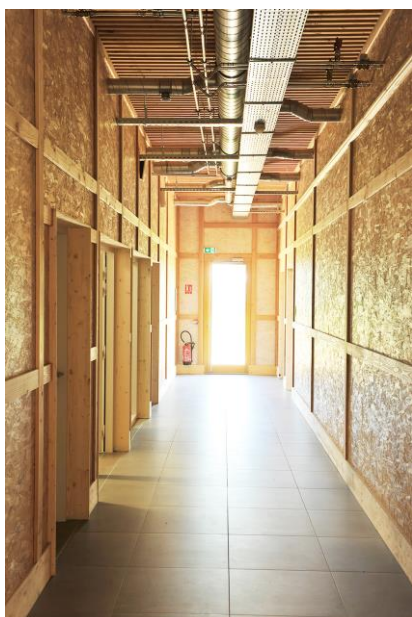
A gauche : Lycée St-Joseph, St-Didier-sur-Chalaronne / à droite : Siège social de Coforet, Lamure-sur-Azergues, crédit photos : studio Gaudin Ramet matériaux du bâtiment Coforet : poteaux Douglas, contreventement apparent : contreplaqué peuplier Drouin 72, plafond Knauf Organic fibre de bois
