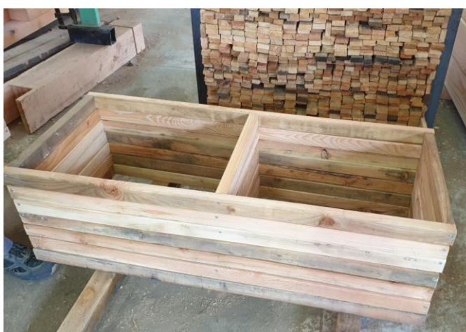
Assemblage des cadres des panneaux Sylvacoustik
