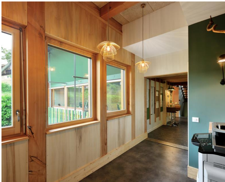
A gauche : Lycée St-Joseph, St-Didier-sur-Chalaronne / à droite : Siège social de Coforet, Lamure-sur-Azergues, crédit photos : studio Gaudin Ramet matériaux du bâtiment Coforet : poteaux Douglas, contreventement apparent : contreplaqué peuplier Drouin 72, plafond Knauf Organic fibre de bois
