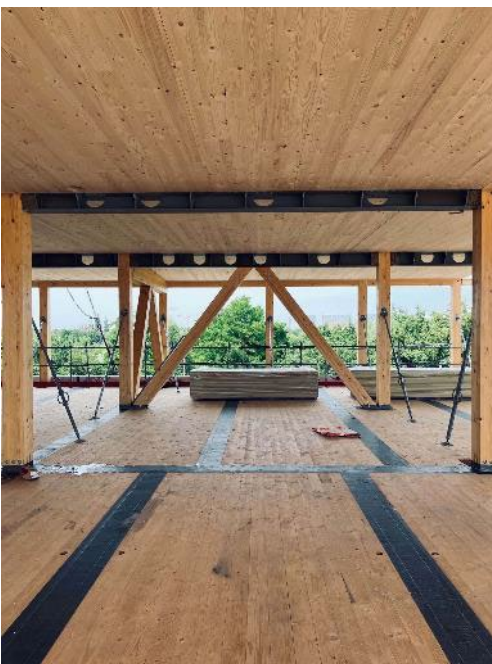
Système poteaux-poutres – façades non-porteuses (photo GBL Architectes)
