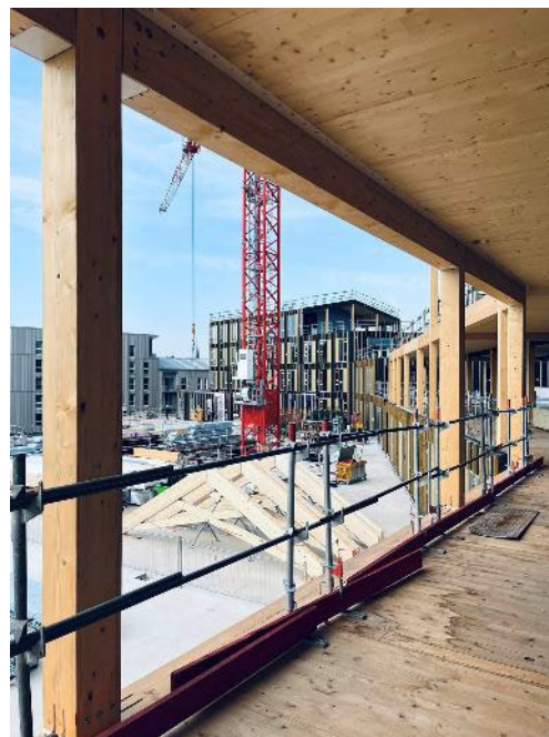
Système poteaux-poutres – façades non-porteuses (photo GBL Architectes)
