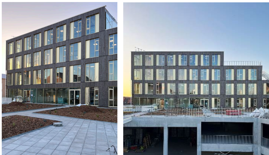
Bardage bois Origine France : Douglas pré-grisé (photo GBL Architectes)
