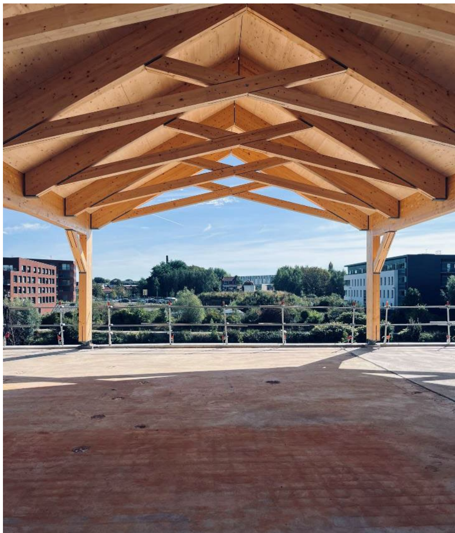
Charpente visible du futur restaurant d'entreprise (photo GBL Architectes)
