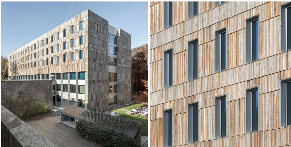
6A architects – Logement étudiants de Cowan Court / Bardage issu du réemploi et poncé sur le motif
