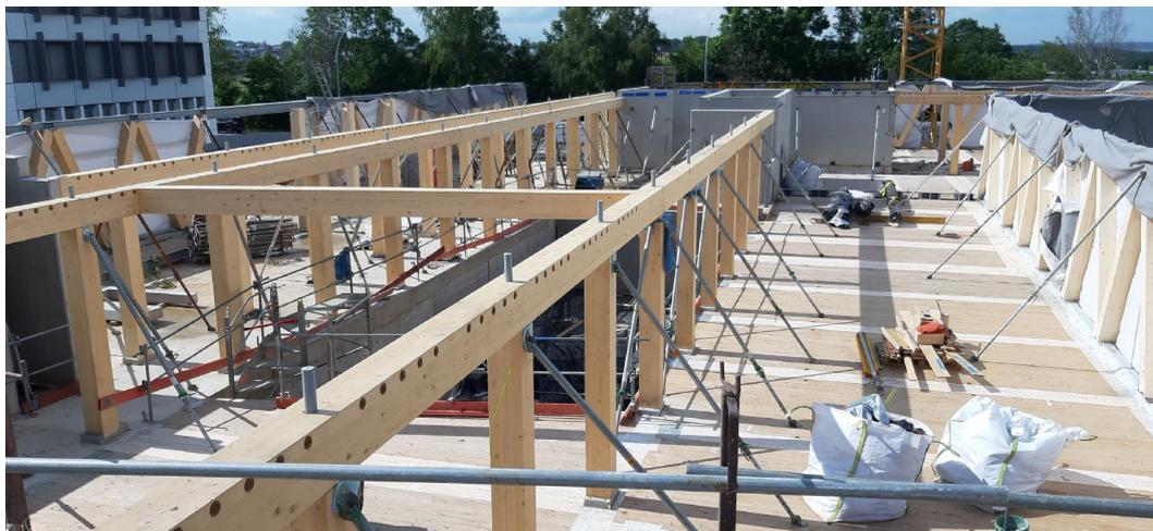
Trame structure intermédiaire avec percements et connecteurs.
