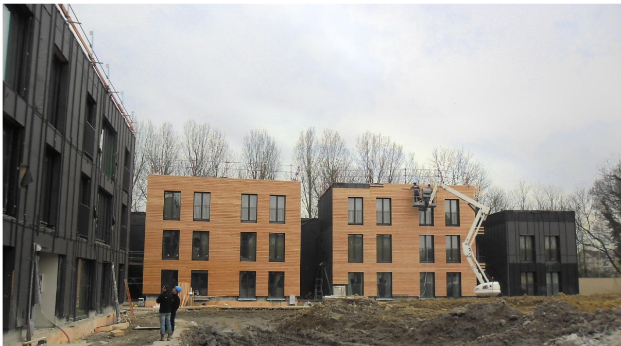
Photo de Chantier Février 2013
