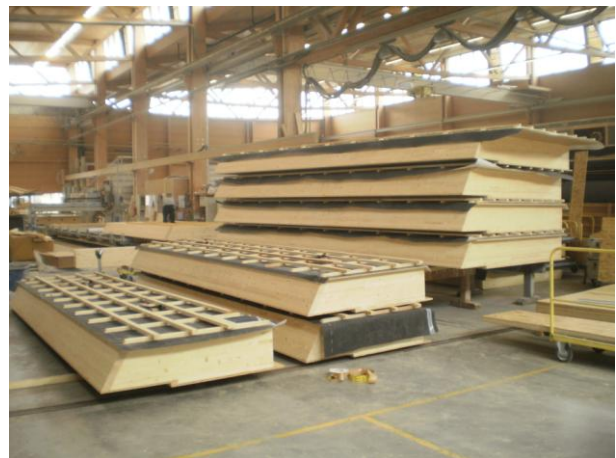
Illustration 12 : préfabrication des éléments de toiture
