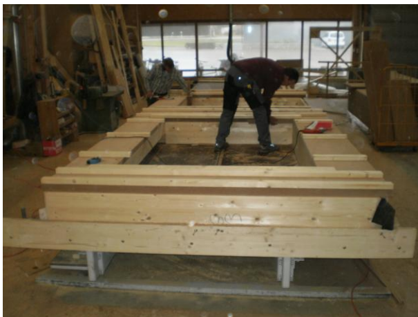
Illustration 11 : Préfabrication des éléments de mur
