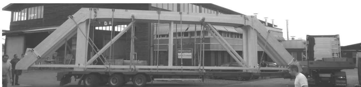
Illustration 6: Photo d'éléments de charpente préassemblés et de leur transport
