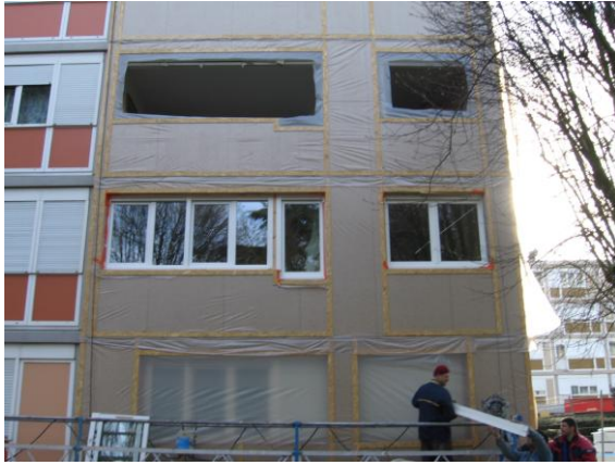
Panneaux extérieurs sont protégés par Polyane et prêts à accueillir les fenêtres
