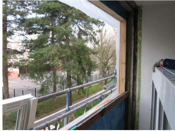
Panneaux extérieurs sont protégés par Polyane et prêts à accueillir les fenêtres
