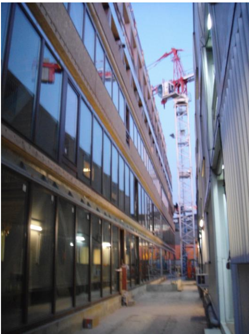
Façades en cours d'habillage
