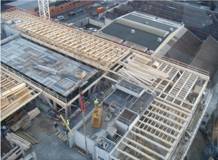
Charpente (niveau haut R + 4) en cours de construction
