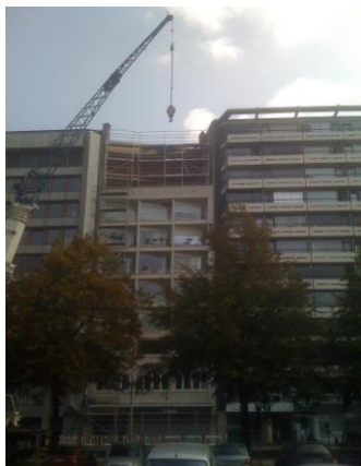
Illustration 7: La préfabrication permet de limiter le temps de montage. Cet avantage est prépondérant particulièrement en situation urbaine et lorsqu'on intervient sur un immeuble occupé, comme c'est le cas dans cet immeuble situé sur une artère fréquentée au centre de Liège. Architecte : Rudolph Stassen, Liège
