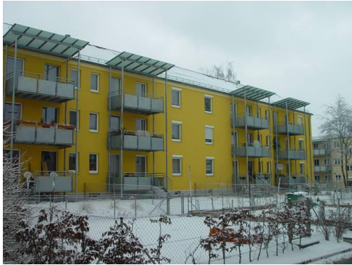
Abbildung 4 : Thermisch getrennte, vor die Fassade gestellte Balkone an Sanierungsprojekt in Nürnberg, Arch. B. Schulze-Darup, Foto M. Ploss
