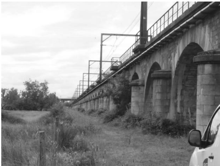
Illustration 2 : Le viaduc des cent arches (ligne SNCF Paris-Bordeaux) aujourd'hui (photo J. Christin)
