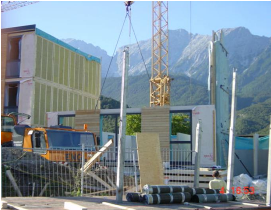
Abbildung 9: Telfs Montage auf der Baustelle, vorgefertigter Sanitärschacht
