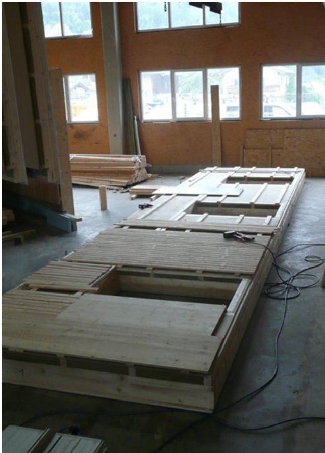
Abbildung 7: Jenbach Vorfertigung in der Werkhalle
