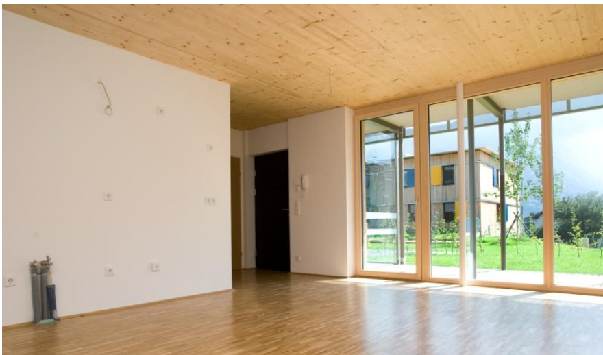
Abbildung 10: Jenbach sichtbare Holzdecken
