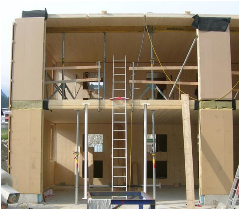
Abbildung 8: Jenbach Montage auf der Baustelle
