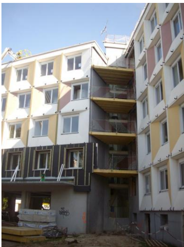
Photo des planchers à ossature bois des cuisines collectives.
