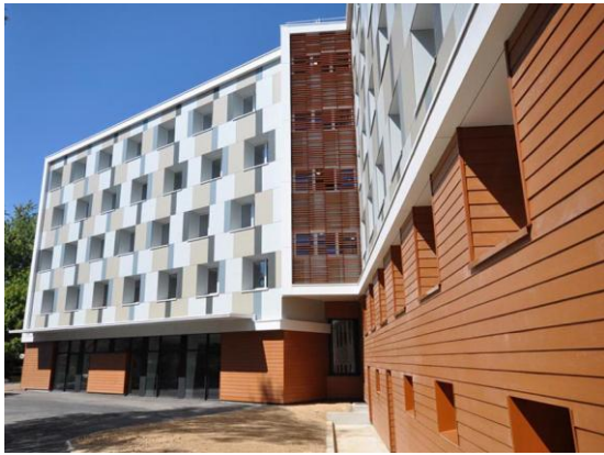
Etat en fin de chantier : photo côté jardin sud
