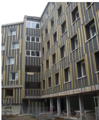
Photo du mur manteau bois préfabriqué (Au nord du site).
