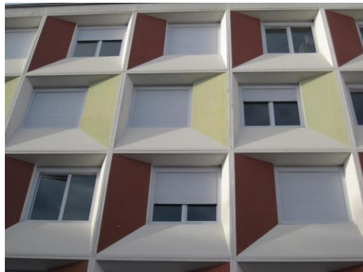
Photo des panneaux en béton architectonique
