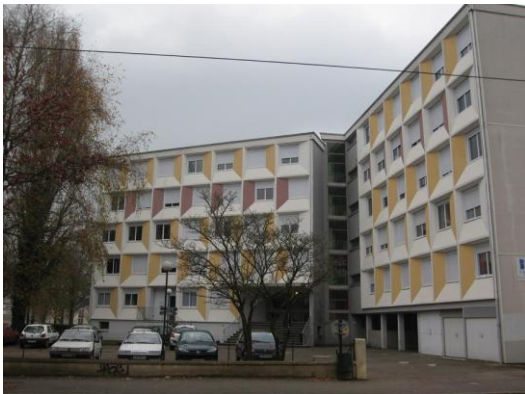
Etat existant : photo depuis la rue principale
