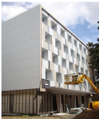
Photo du bardage sur ossature bois (Pignon ouest).
