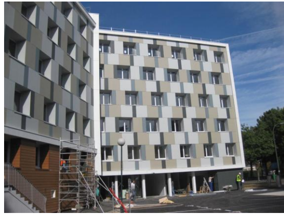
Photo côté parking nord
