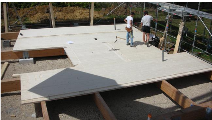
Image 11: Massifs en béton, structure en lamellé collé et dalle bois
