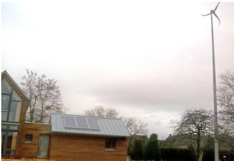
Image 13: pose de l'éolienne
