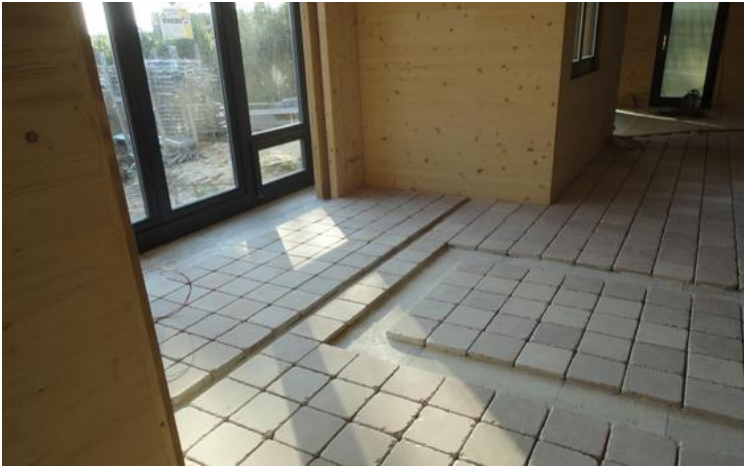
Image 10: inertie thermique au sol
