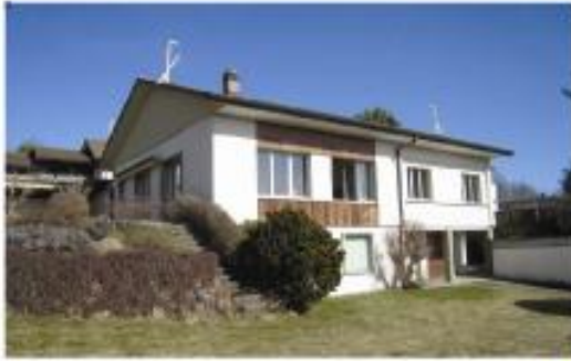
Rénovation à Villars-sur Glâne 1ère maison rénovée, labellisée Minergie-P du canton de Fribourg.
