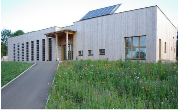
Premier bâtiment bois construit en Bourgogne au standard passif - 2007 Salle communale de Savigny le Sec (département de Côte d'Or) Maître d'ouvrage: commune de Savigny le Sec, Architecte: TOPOIEIN Studio, BET: CIE DUPAQUIER).
