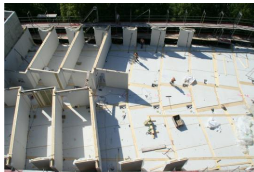
Montage modulartiger Zimmeraufbau
