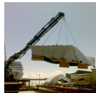
Abb. 10: Transport von bis zu 50m 2 grossen Elementen per Schiff. ©Trebyggeriet
