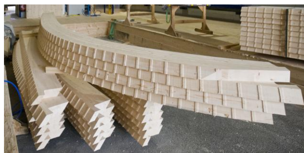
Abb. 5: CNC-gefäste Nuten helfen bei der exakten Positionierung der Schalbretter entlang der gekrümmten Träger.
