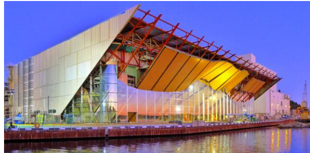
Abb. 12: Montage der Fassadenelemente. ©Trebyggeriet
