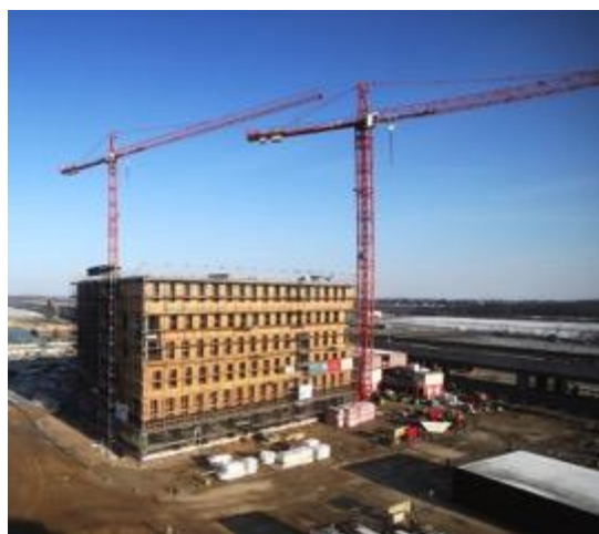
HoHo à Vienne, Architecte Richard Woschitz © cetus Baudevelopment GmbH
