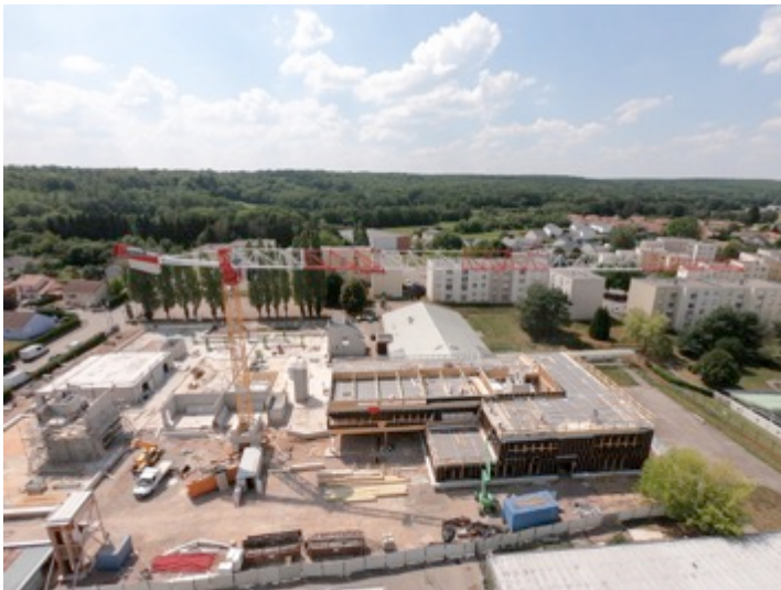
Chantier du Collège Elsa Triolet à Thaon-les-Vosges
